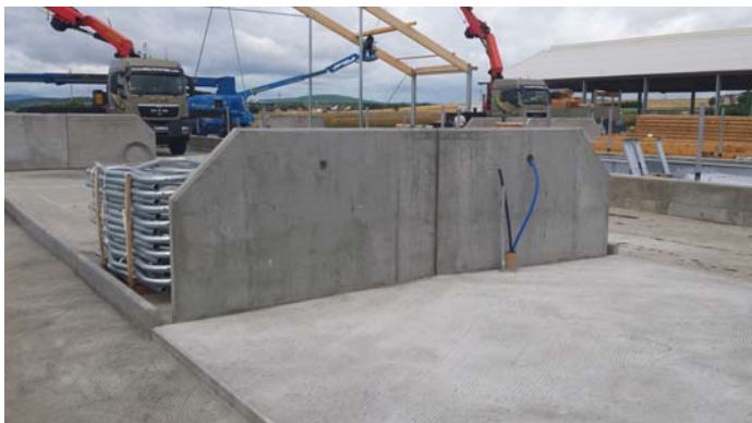
abgeschrägte Form mit Anschlusseisen zum Einbetonieren
