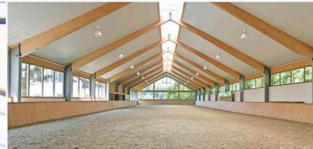
Verzinkte Stahl-Brettschichtholz-Rahmen, Dachaufbau mit Pfetten, Ziegeleindeckung, Kunststoffdecke als Untersicht, große Belichtungsflächen an Seiten- und Giebelwänden
