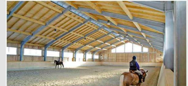
Verzinkte Stahlrahmenkonstruktion ohne Zugband, Sparrendachstuhl mit Ziegeleindeckung, Wandverkleidung in Holz
