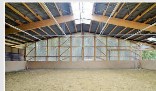
Lüftung mit Lochblech-Giebelwand
