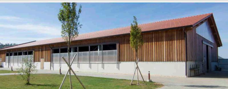
Seitenlüftung mit Licht-Lüftungsschieber
