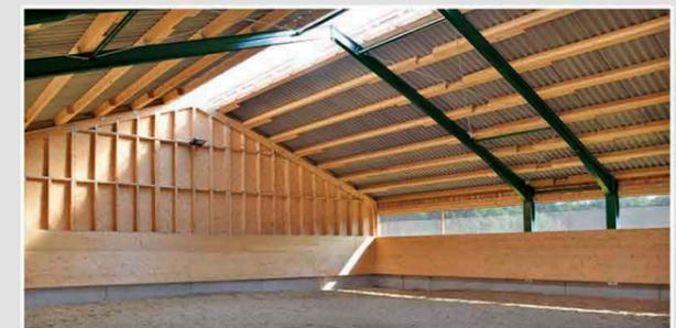
Giebelwand in Holzfachwerkkonstruktion, farbbeschichtete Stahlrahmenkonstruktion, Dacheindeckung mit Wellfaserzementplatten, Firstlichtband und Holzkoppelpfetten, Seitenwandbelüftung
