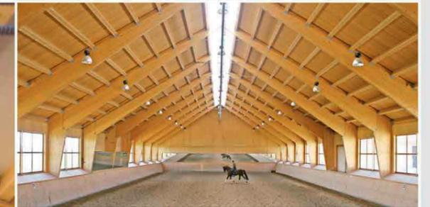
Brettschichtholzrahmen, Holzeinfeldpfetten mit Ziegeleindeckung und Lichtfirst, Brettschichtholzdecke als Untersicht, Wandbelichtungsflächen
