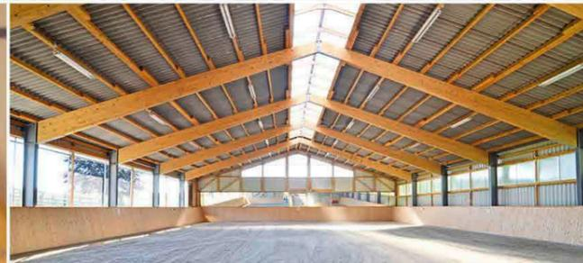
Giebelwand in Holzfachwerkkonstruktion, verzinkte Stahl-Brettschichtholzkonstruktion, Holzkoppelpfetten mit Wellfaserzementplatten-Eindeckung und Lichtfirstband, Wandverkleidung in Stahltrapezblech, Belichtungs- und Belüftungsflächen
