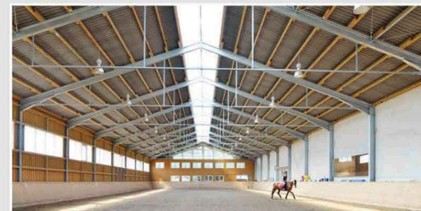
Verzinkte Stahlrahmenkonstruktion mit Zugband, Holzkoppelpfetten mit Dacheindeckung in Wellfaserzementplatten, Außenwände mit Holzverschalung
