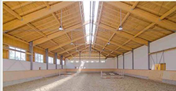
Verzinkte Stahl-Brettschichtholz-Rahmen mit Zugband, Sparrendachstuhl mit Ziegeleindeckung, Firstlichtband, Wände aus weiß gestrichenen Betonfertigteilen bzw. mit Holzverschalung
