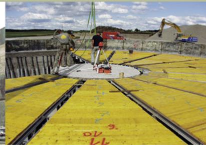
Verlegen der vorgefertigten Deckenelemente
