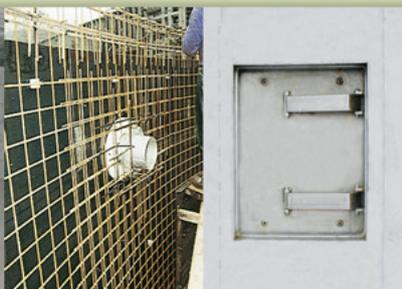
Details: Einbauten, Wanddurchführungen, Biogas-Mannluken aus Edelstahl
