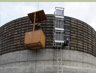
Wolf System Baustellen-Sicherheitssysteme: z.B. patentierte, elektrische Ausschalvorrichtung mit Sicherheits-Montagekorb (Abb. oben)
