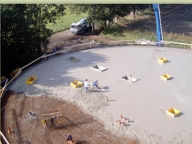
Armieren und Betonieren der Behälterdecke
