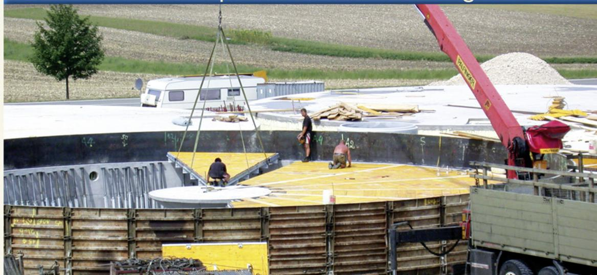
Die von WOLF SYSTEM entwickelten und produzierten SPEZIAL-METALLSCHALUNGEN haben sich in jahrzehntelangen härtesten Einsatz bestens bewährt. Diese technologisch ausgereiften Schalungen sind die Grundlage des europaweiten Erfolges von WOLF SYSTEM im Rundbehälterbau. Durch ständige Weiterentwicklung und notwendige innovative Anpassungen werden wir den sich ständig ändernden Anforderungen bestens gerecht!
