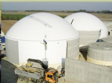
Spezielle, dem jeweiligen Verwendungszweck entsprechende, Ausführungen wie Isolieren und Verkleiden der Wand sowie unterschiedliche Planen-Abdeckungen des Behälters
