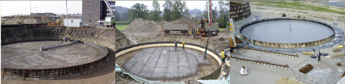
Armierung, Abschalen und Betonieren der Bodenplatte
