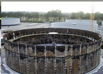
...die fast fertige Wandschalung mit geschalter Mittelstütze
